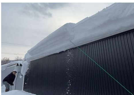
人力による切断作業 -3
