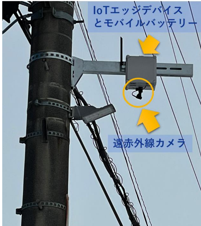
図 2-4 カメラボックスを電柱（高さ4.5m）に設置した状態
