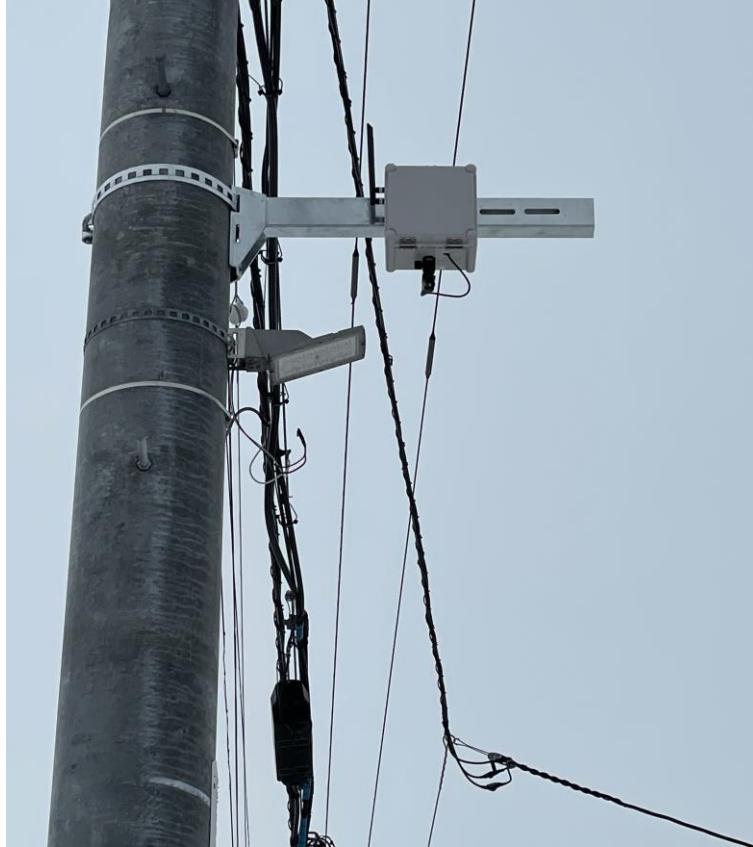
図 3-5 電柱に取り付けた遠赤外線カメラとIoTエッジデバイス
