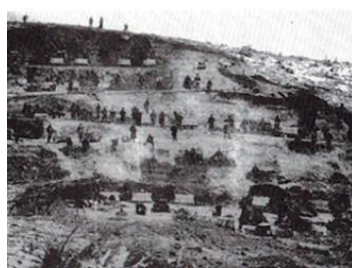
段々に崩す作業現場
