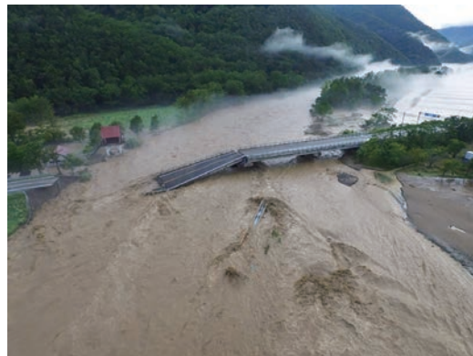
流された千呂露橋（沙流川）
