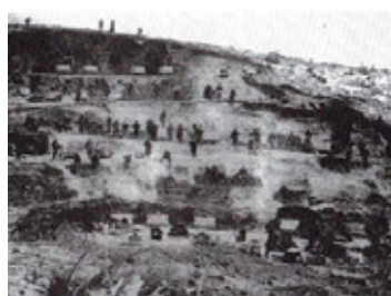
段々に崩す作業現場
