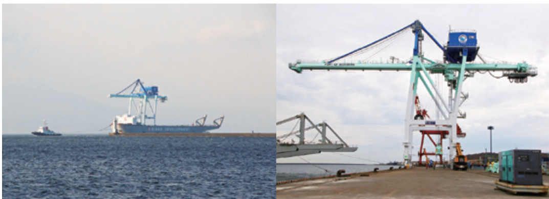
崎守埠頭のガントリークレーン（主に鉄製品などをつみ出します）
