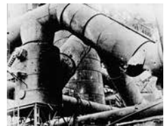
製鉄所の被害
