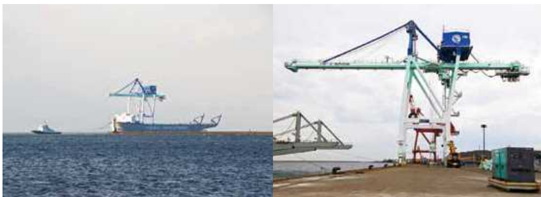
崎守埠頭 ふとう のガントリークレーン（主に鉄製品などをつみ出します）
