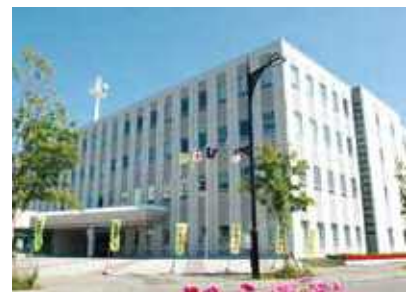
むろらん こういき 広域センタービル
