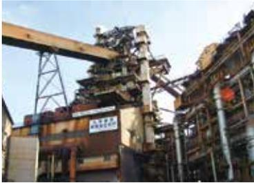
鉄こう石を溶かして銑鉄をとりだす高炉(左)
